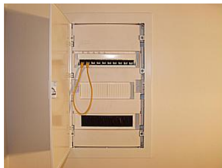
Obr. 3 – Bytové rozvaděče (dvou a jednokabelové) bez brány (dva / jeden přívodní (žluté) kabely)
