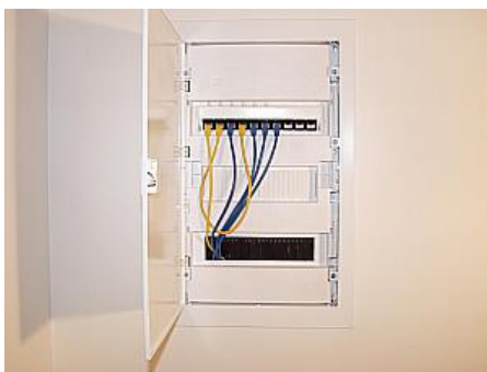
Obr. 2 – Bytové rozvaděče (dvou a jedno kabelové) s branou (dva / jeden přívodní (žluté) kabely)
