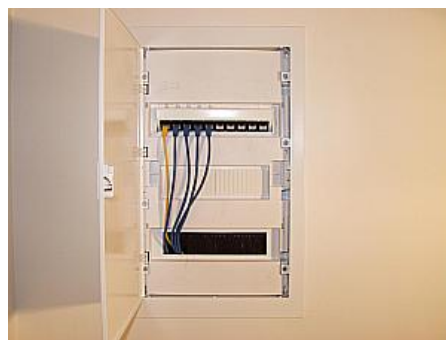
Obr. 2 – Bytové rozvaděče (dvou a jedno kabelové) s branou (dva / jeden přívodní (žluté) kabely)
