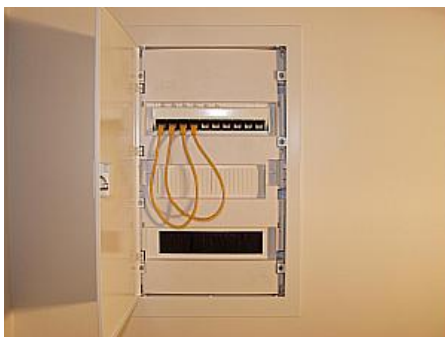
Obr. 3 – Bytové rozvaděče (dvou a jednokabelové) bez brány (dva / jeden přívodní (žluté) kabely)
